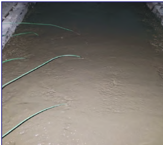
Şekil 4. Beton yüzeydeki termokupullar
