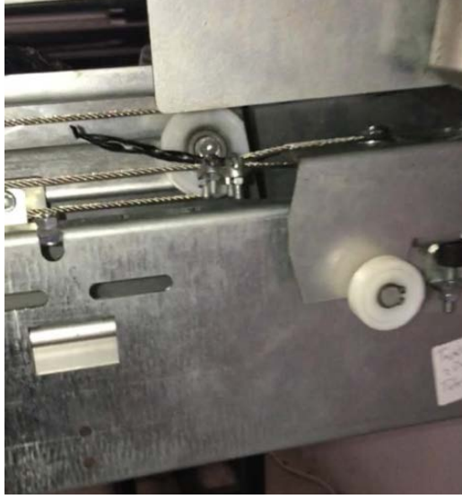
Resim 12. Dinamik testi yapılan kat kapısı kilitleme tertibatı
