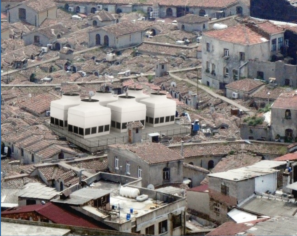
Çatı Alanının Genel Görünümü
