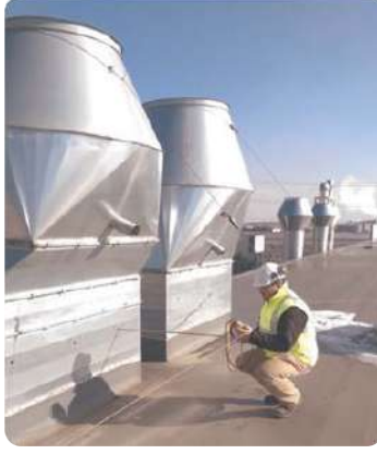
Havalandırma Fanları Kapasite Ölçümü
