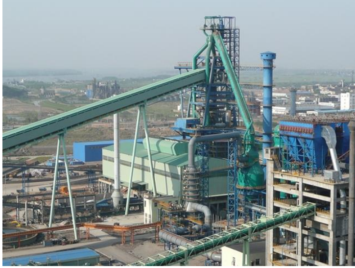
Fotoğraf 4.1 Entegre Bir Demir Çelik Fabrikasında Yüksek Fırın Görünüşü
