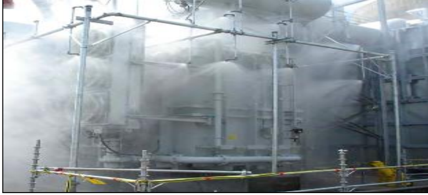
Fotoğraf 20.9 Deluj Sistemi Test Çalışması
