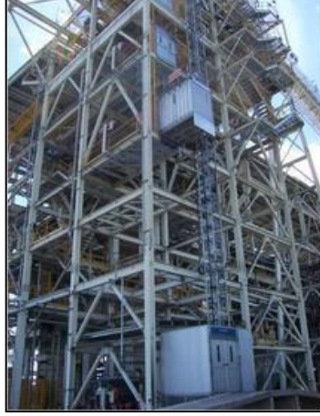
Fotoğraf 22.2 İnşaat Asansörü
