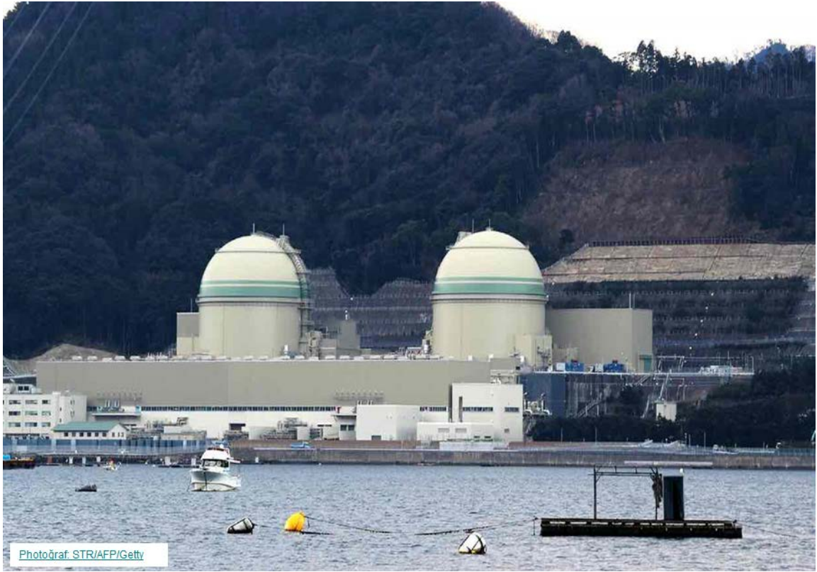
Şekil 9.2.3 Takahama Nükleer Santrali
