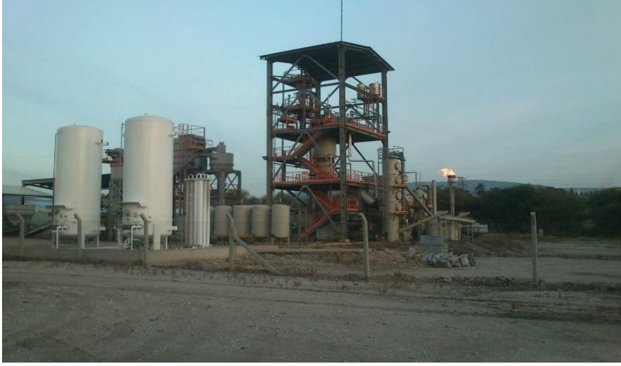
Şekil 5.6 250 t/h Kapasiteli Sürüklemeli Tip Gazlaştırıcı
