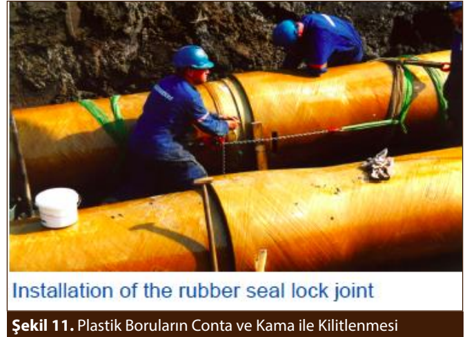
Şekil 11. Plastik Boruların Conta ve Kama ile Kilitlenmesi
